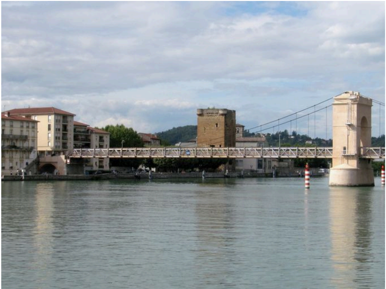
Vue partielle, travée droite, face aval (depuis la rive gauche)
