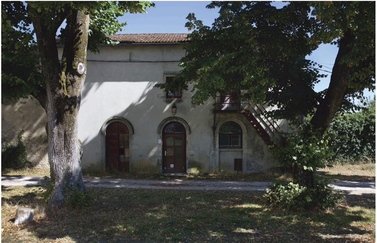
Elévation latérale sud
