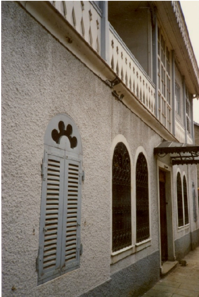
Elévation postérieure, partie basse, avant démolition
