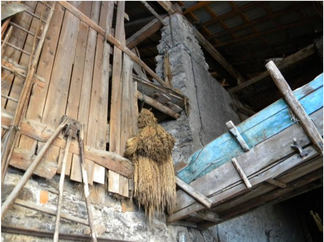
Vue d'une passerelle entre la grange et le bûcher.
