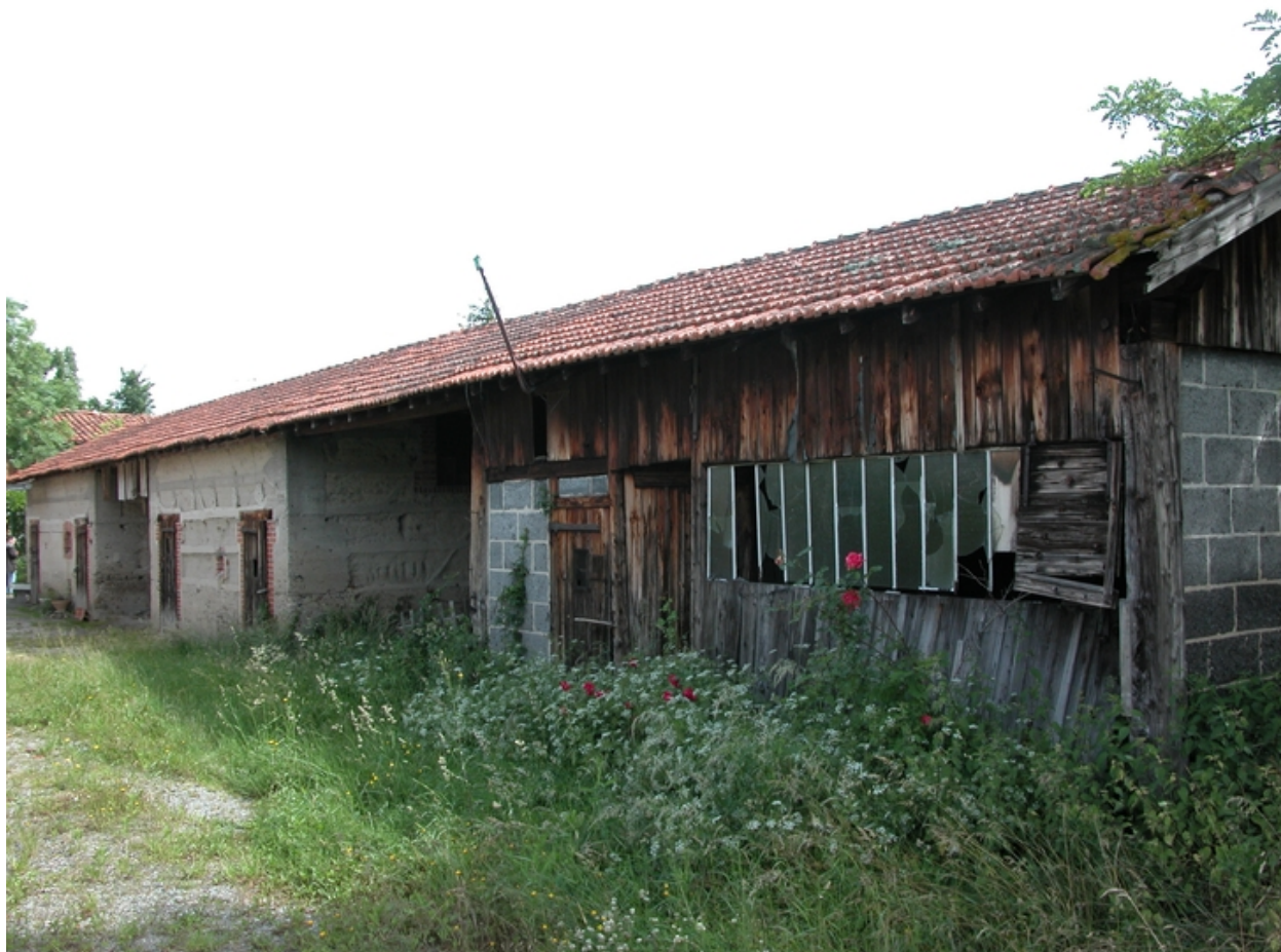
Vue du bâtiment des remises (troisième barre), depuis le sud-ouest.
