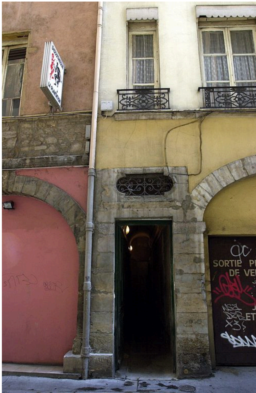
La porte d'entrée surmontée d'un jour oblong
