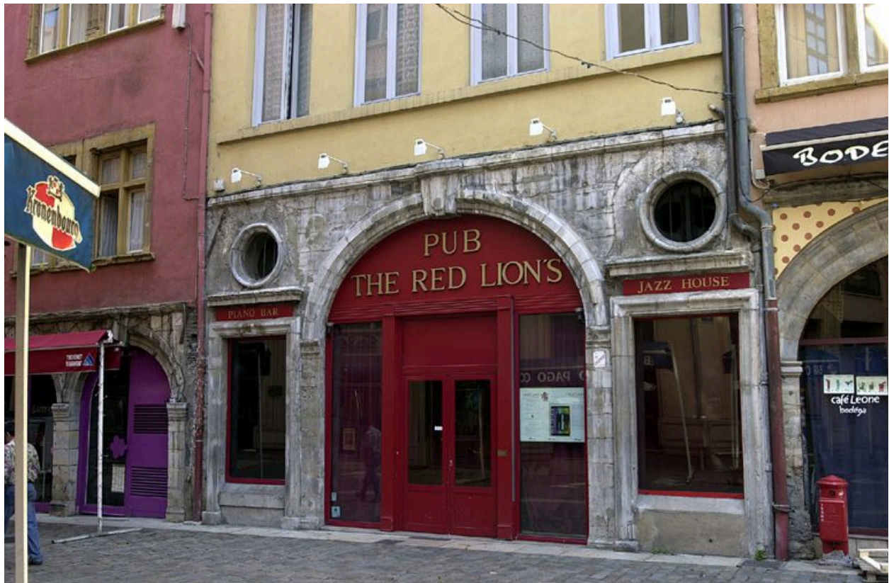
Elévation rue de la Monnaie : le rez-de-chaussée
