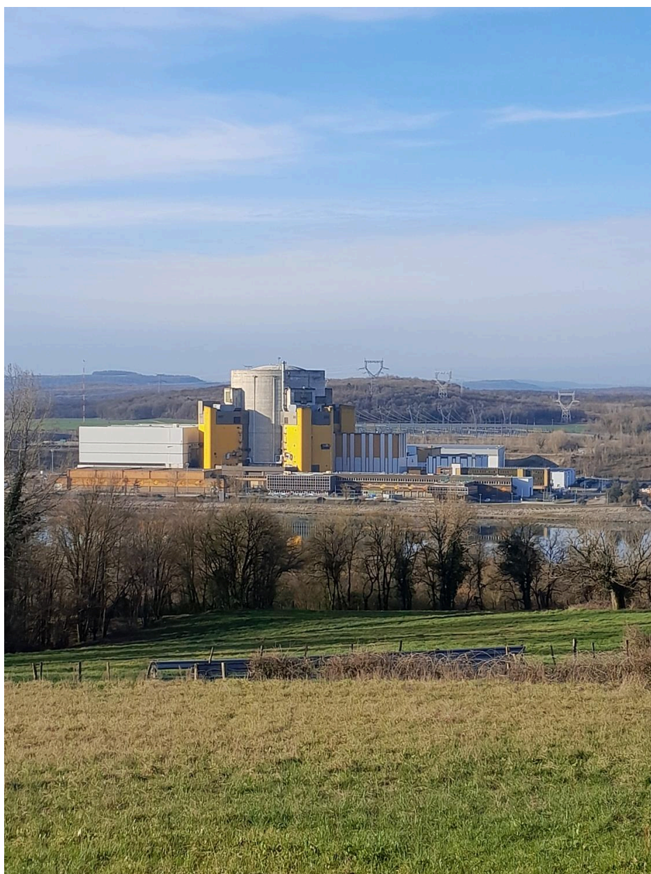
Centrale nucléaire de Creys-Malville
