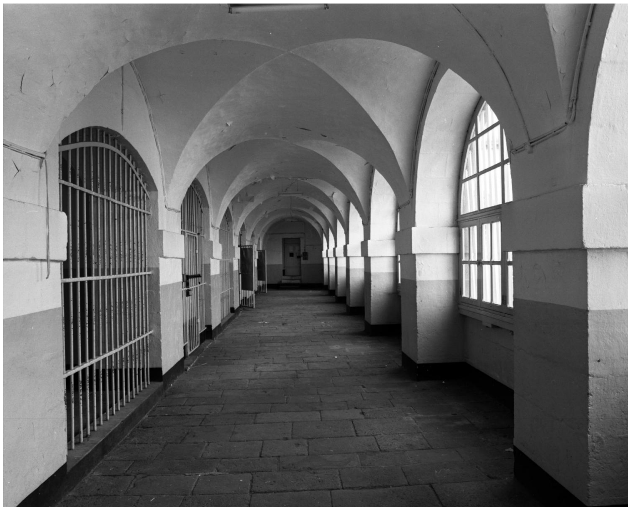
Bâtiment F (démoli après 1986, date du cliché). Galerie-haute s'éclairant sur la seconde cour.
