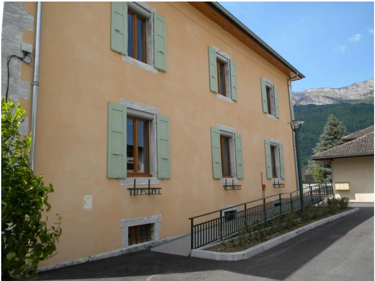
Vue de la façade nord.
