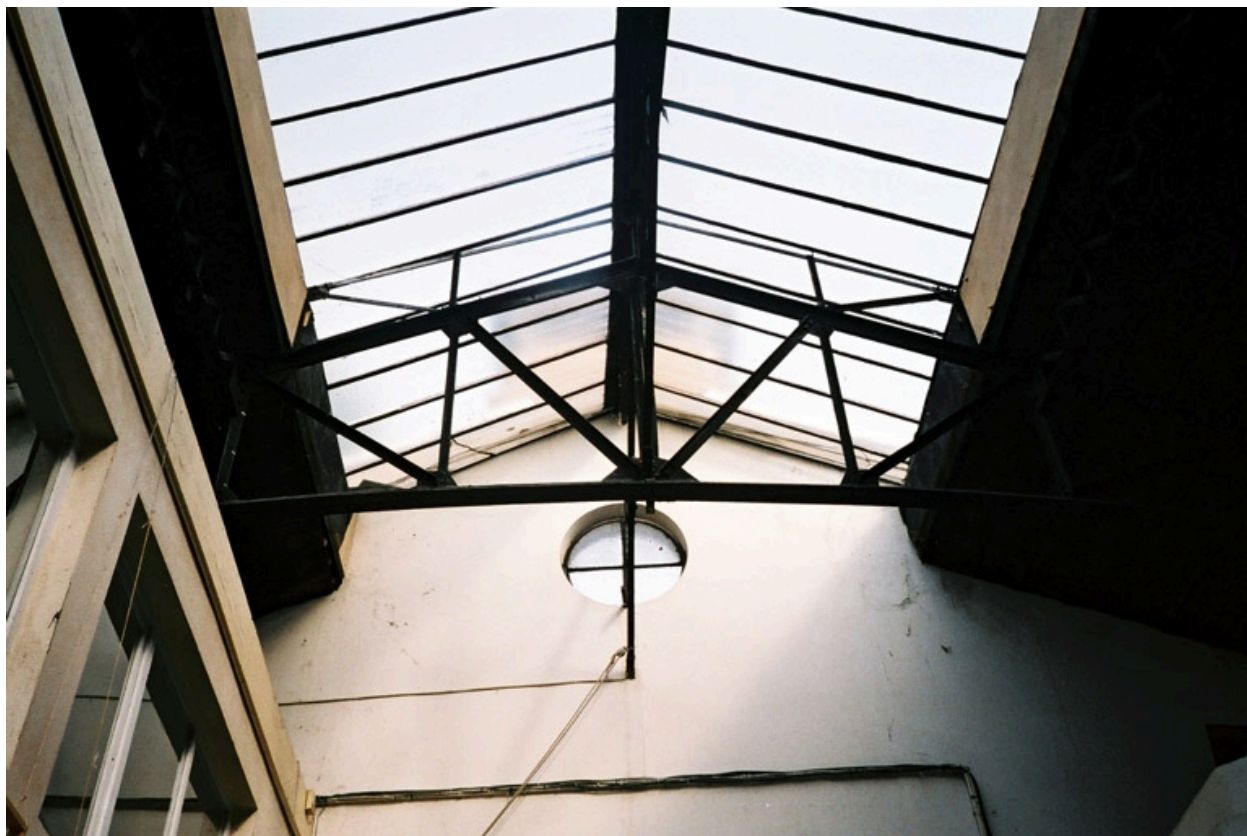
Théâtre, vue intérieure, détail charpente
