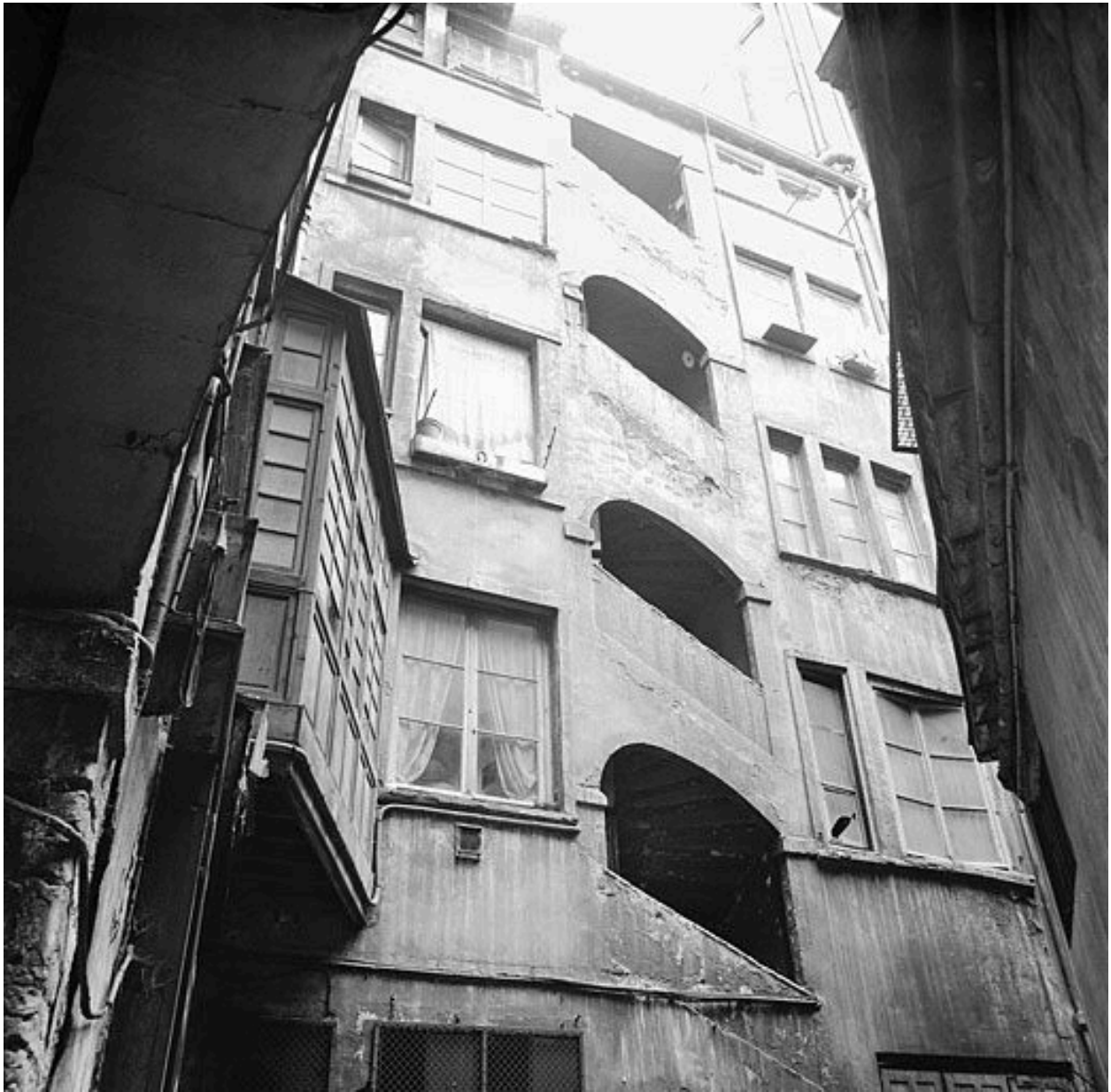
La cage d'escalier à partir du deuxième niveau
