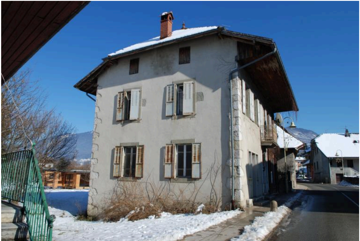
Vue d'ensemble de trois-quarts avant gauche.
