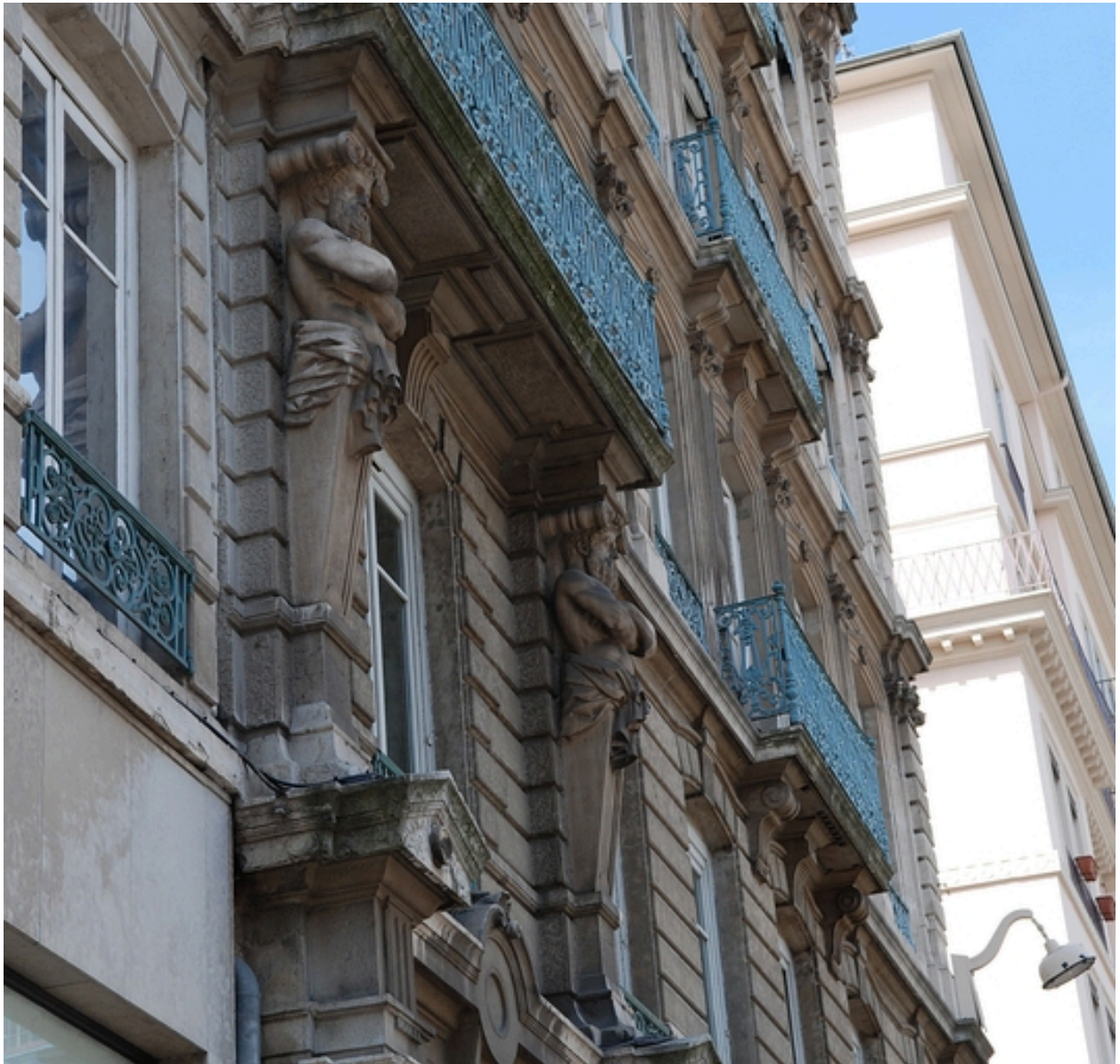
Elévation place des Jacobins : travée axiale, les atlantes
