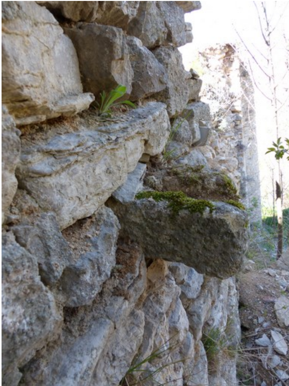
Elévation nord, extrémité orientale. Evacuation en pierre de taille.
