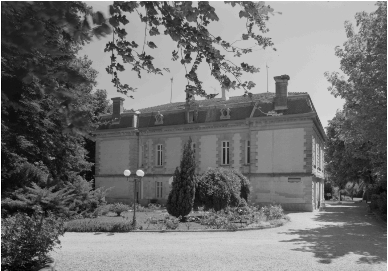
Vue de la façade antérieure de la maison.
