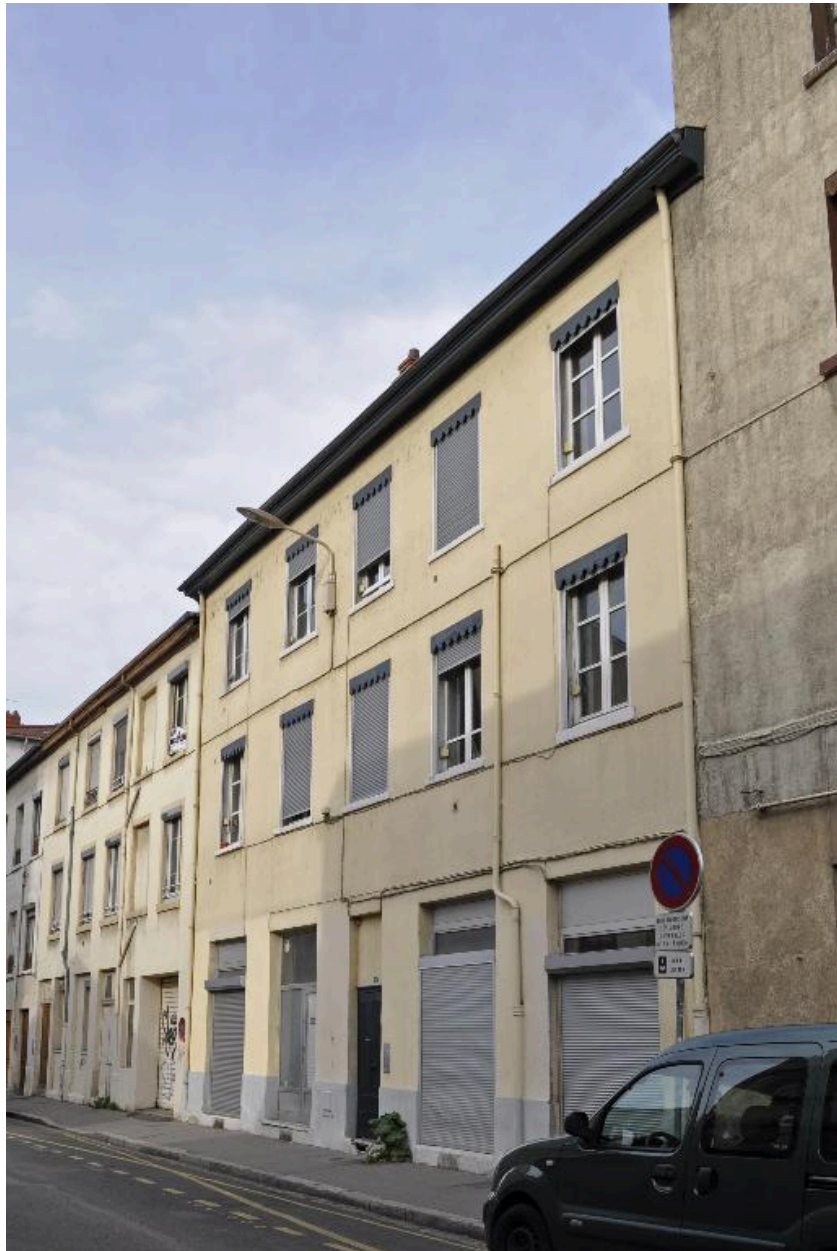
Immeuble sur rue, vue de l'élévation antérieure
