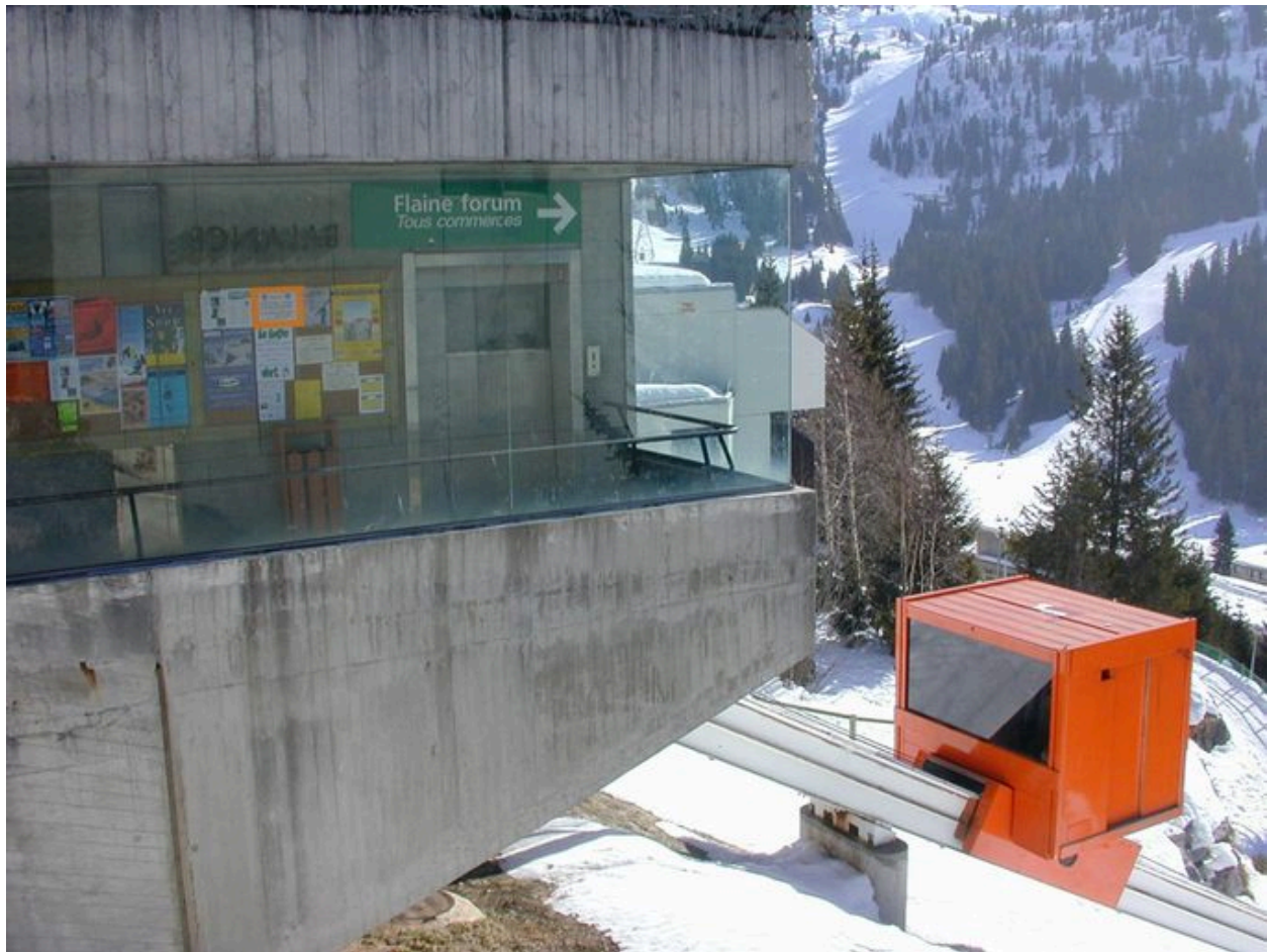
Le départ de la cabine d'ascenseur
