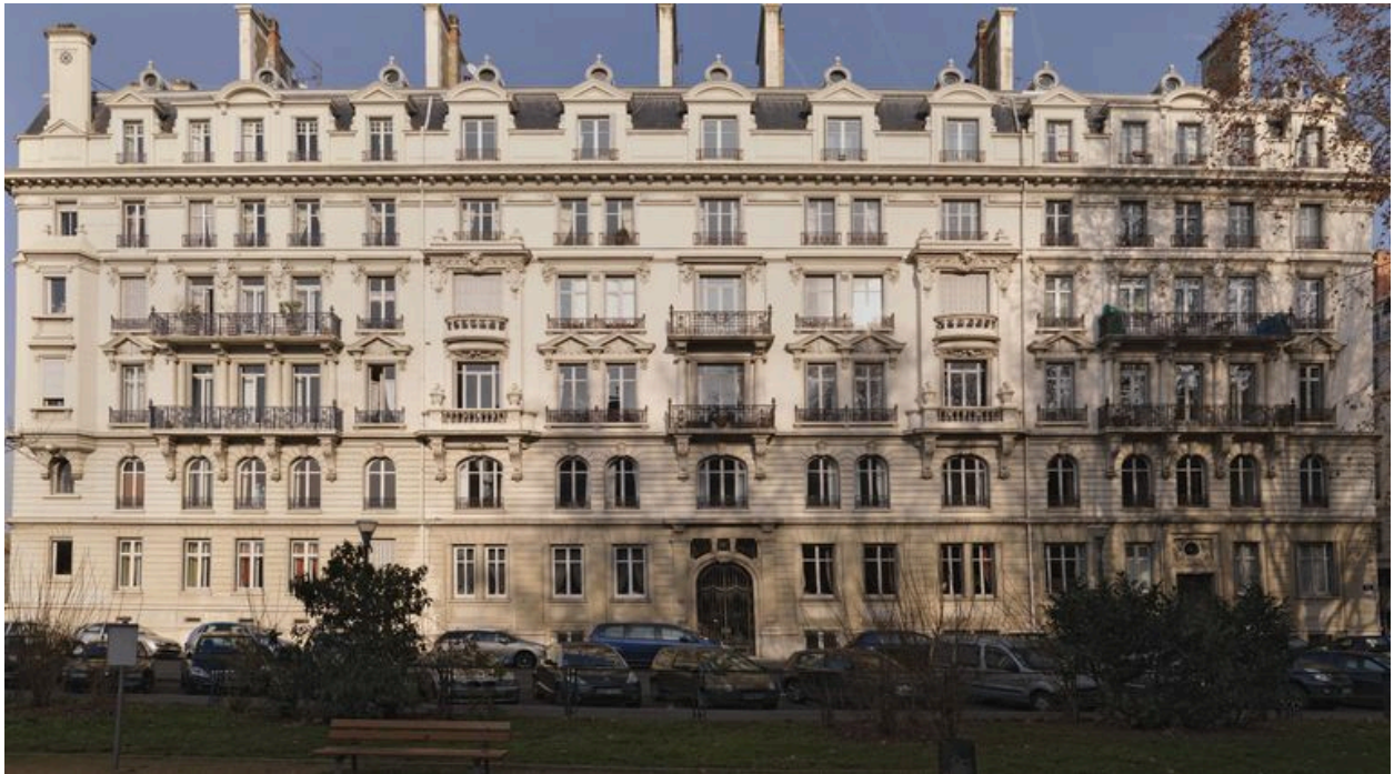
Vue générale de l'élévation sur la place Ollier.
