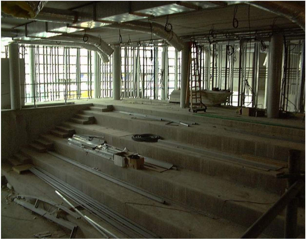
L'auditorium en cours de construction, 23 mars 2000
