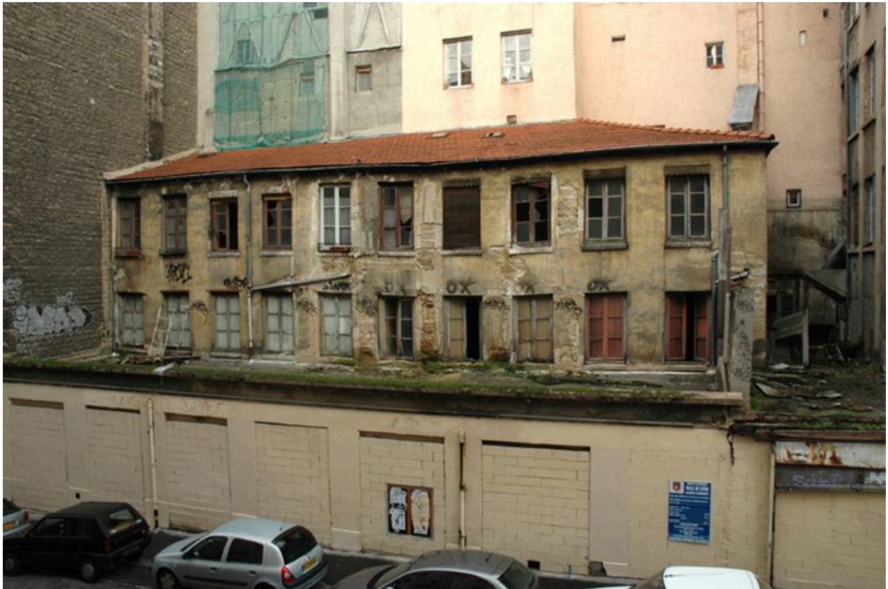
Élévation antérieure et garages au niveau de la rue
