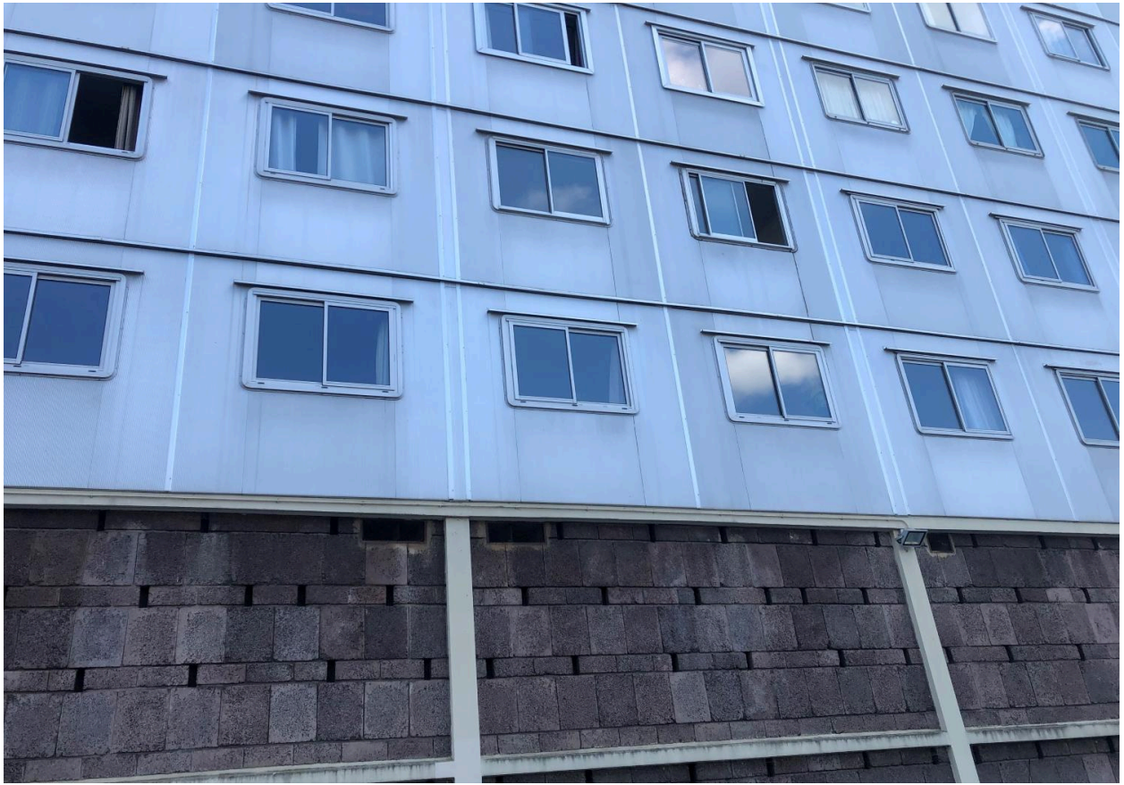
Façade nord et détail soubassement apparent
