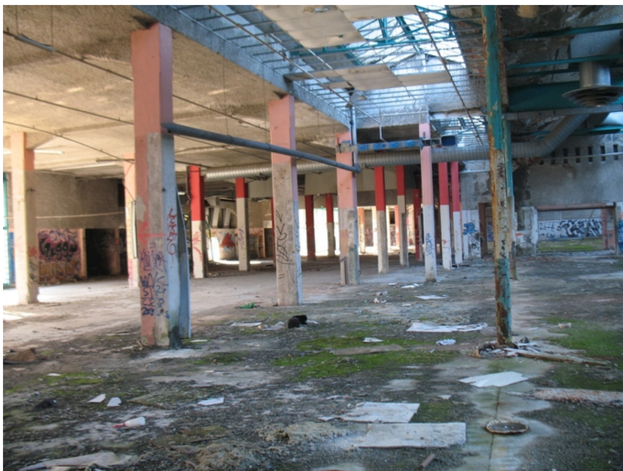
Pilier métallique des ateliers en shed
