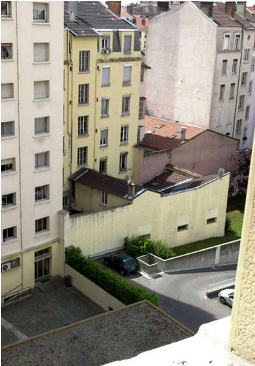
Vue d'ensemble depuis le nord-ouest : les toits du bâtiment industriel
