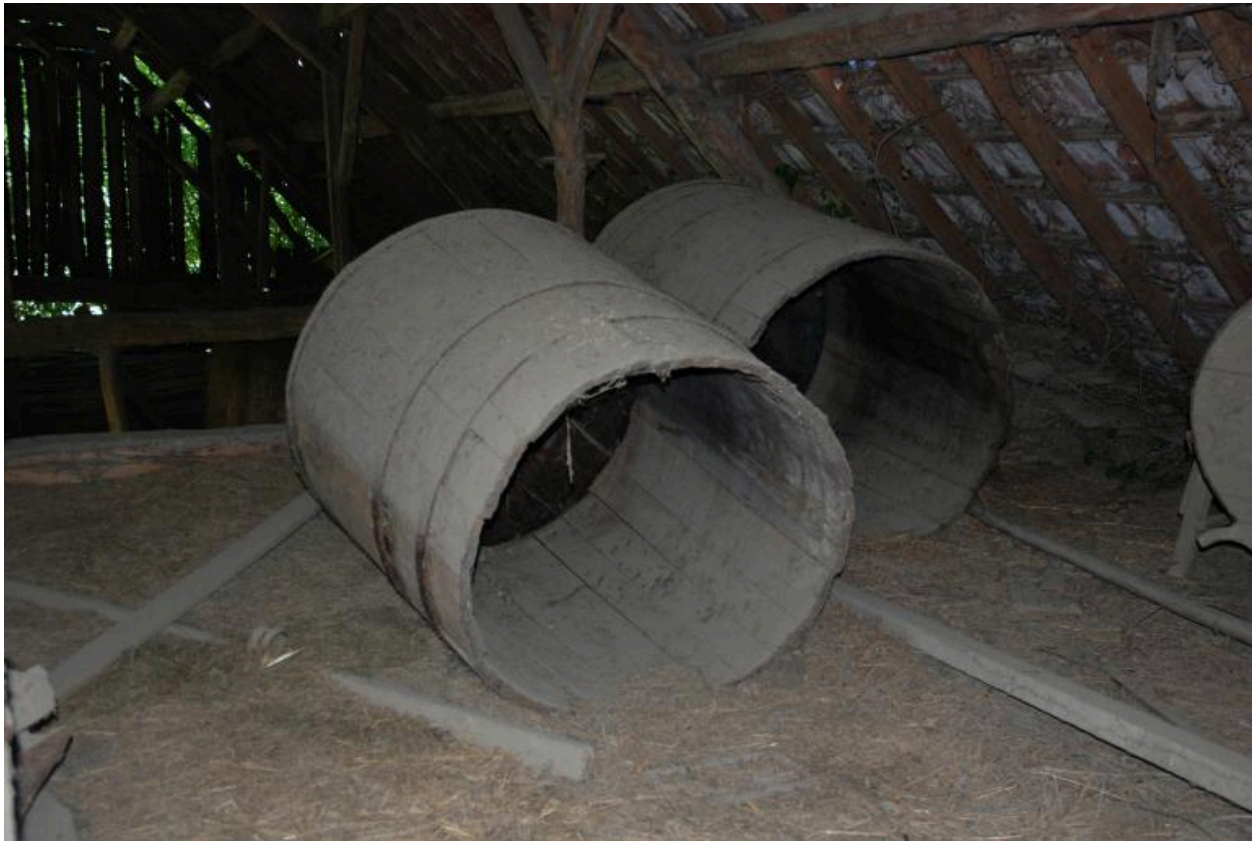
Vue intérieure du comble : cuves à grain.
