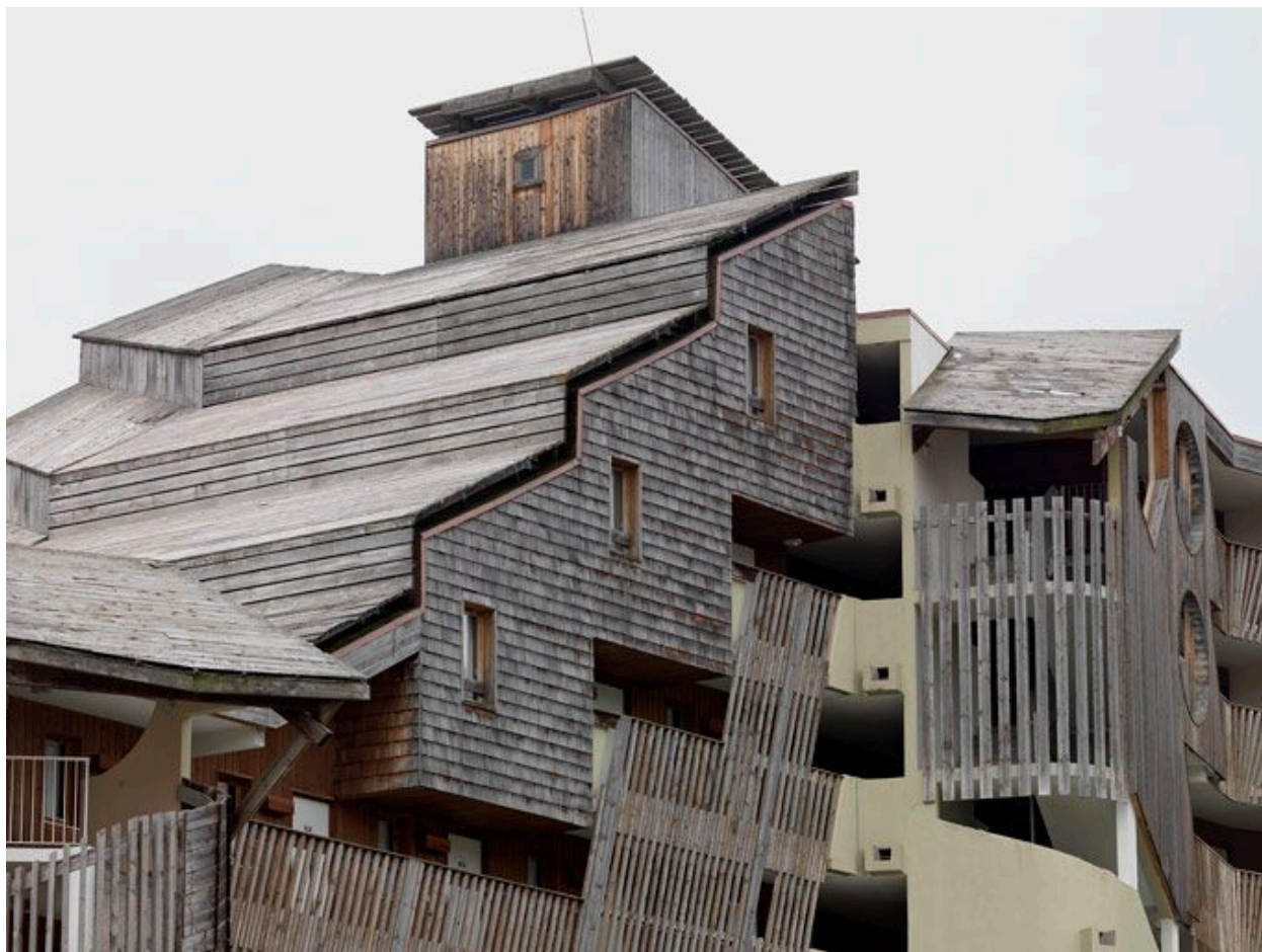
Détail de la toiture
