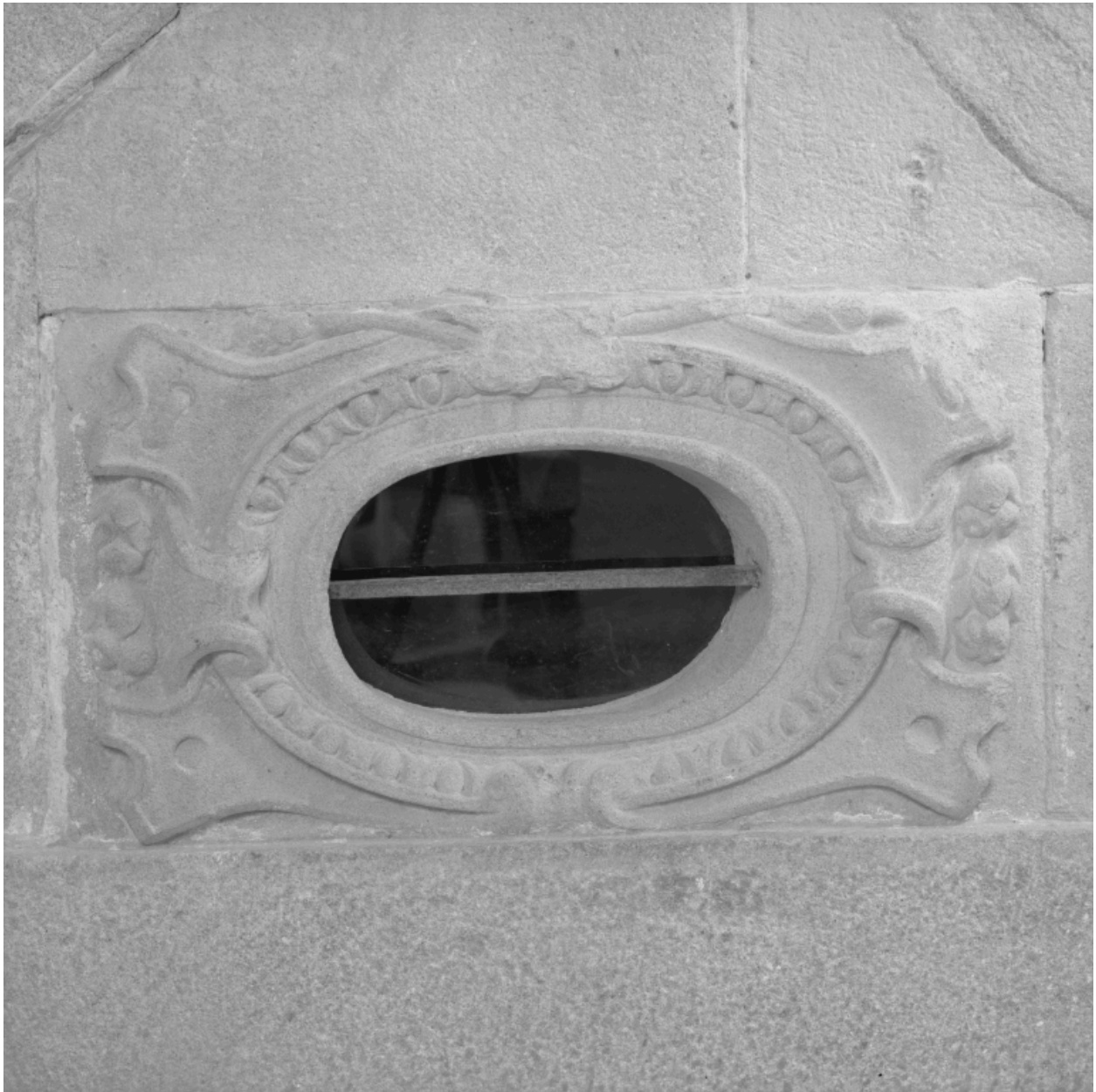
Corps de logis central, rez-de-chaussée, départ de l'escalier : détail intérieur de l'oculus réemployé.
