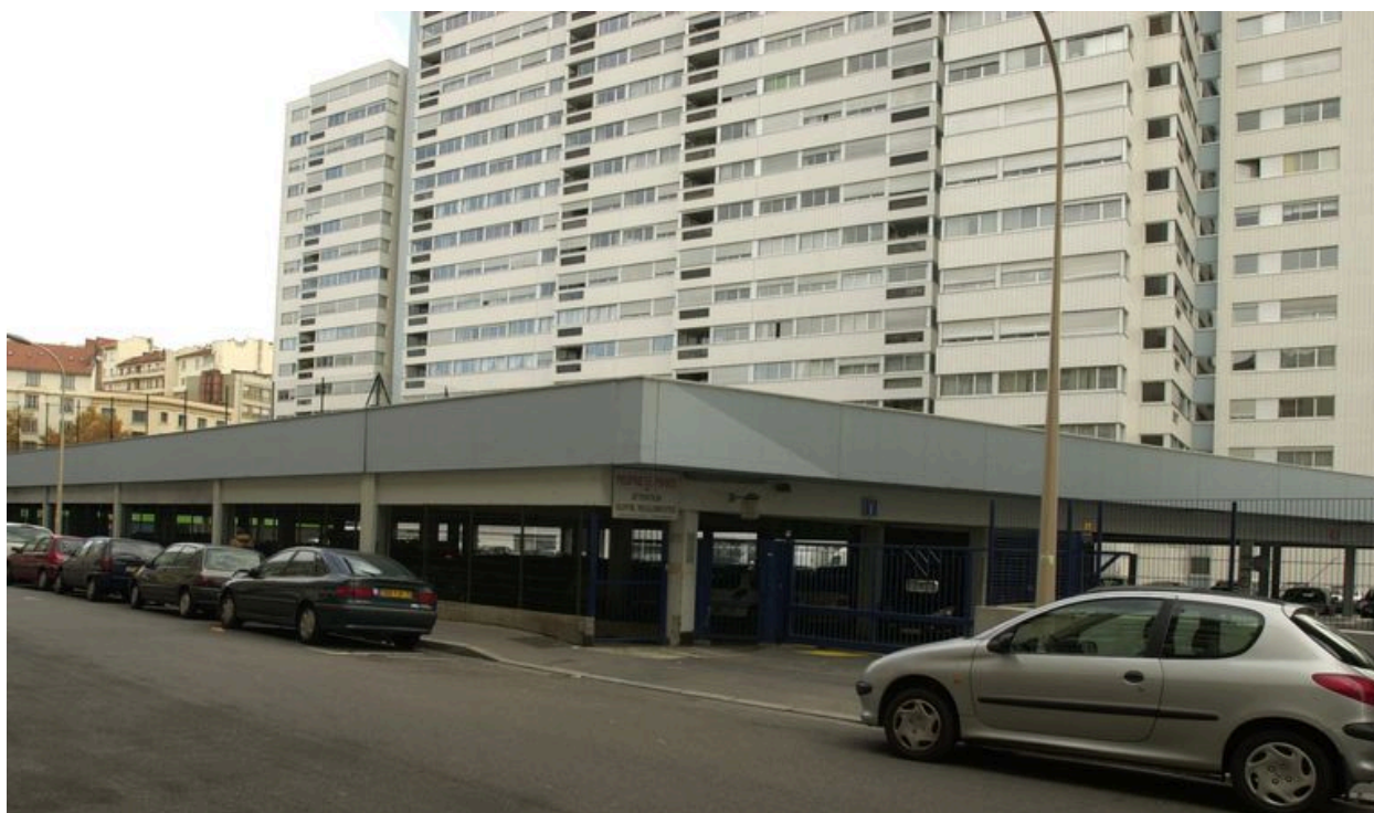
Vue d'ensemble du parc de stationnement, rue André-Philip
