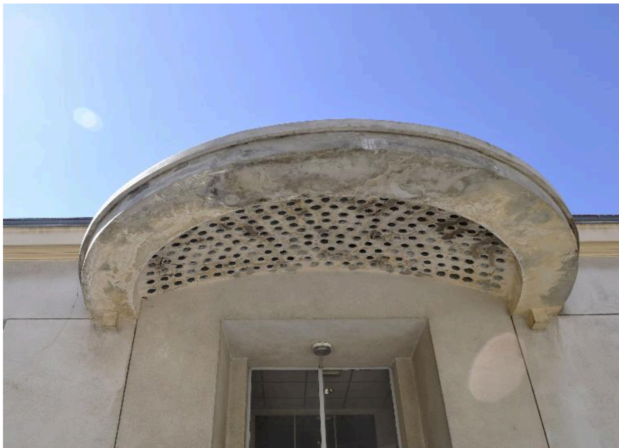
Détail de la marquise
