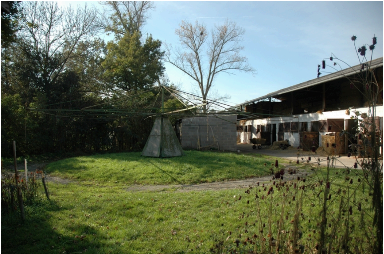
Vue de l'étable à chevaux et du manège édifiés au sud.
