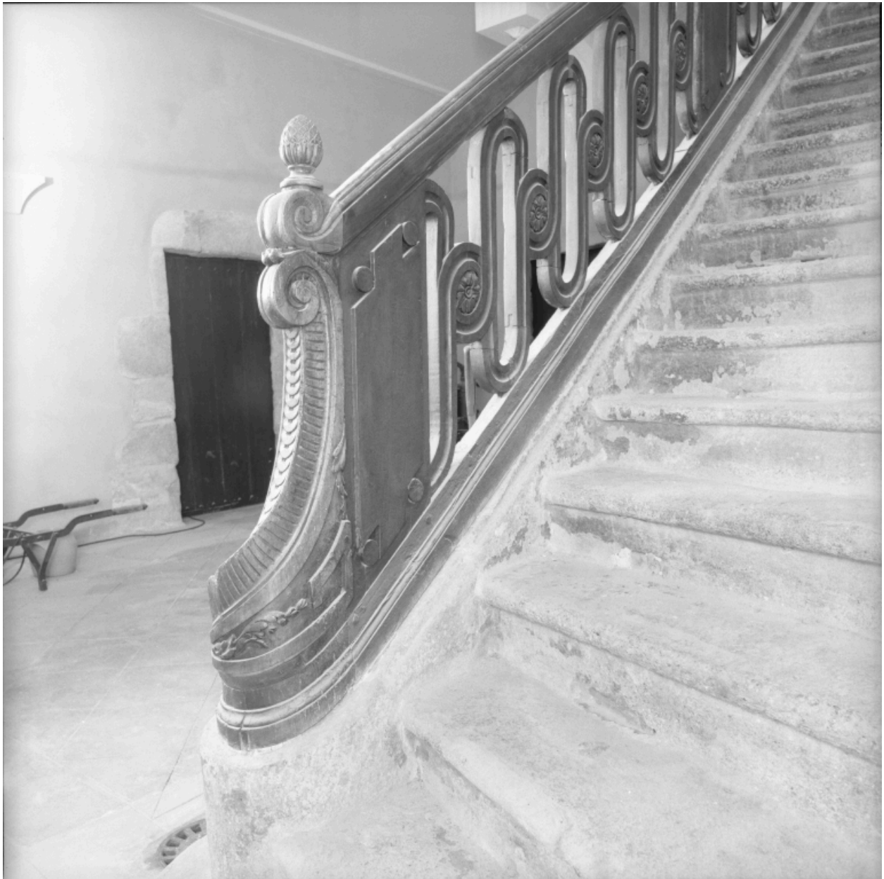
Etage de soubassement : détail du départ de l'escalier.
