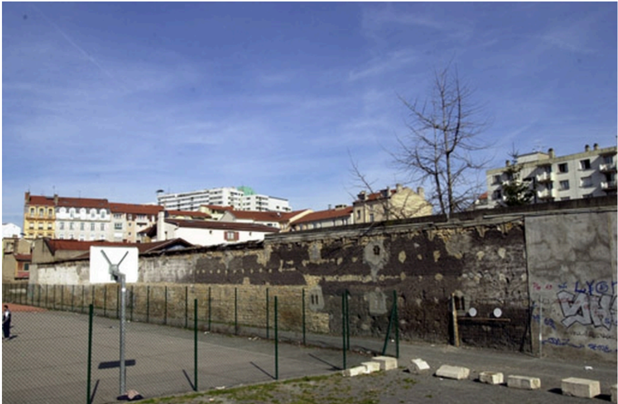
Vue de la façade sud-ouest des ateliers
