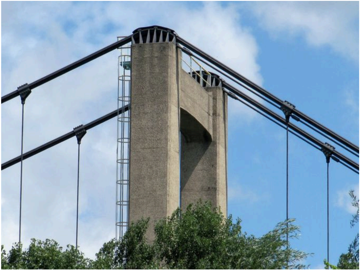
Pylône gauche, face aval, vue partielle : sommet (depuis la rive gauche)
