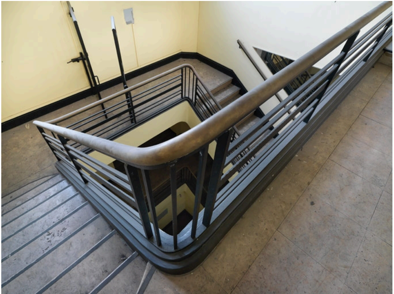
Bâtiment A'. L'escalier depuis le dernier palier
