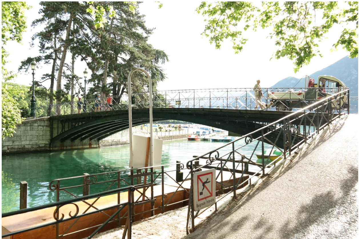
Passerelle du jardin public, dit Pont des Amours, vue de la face aval
