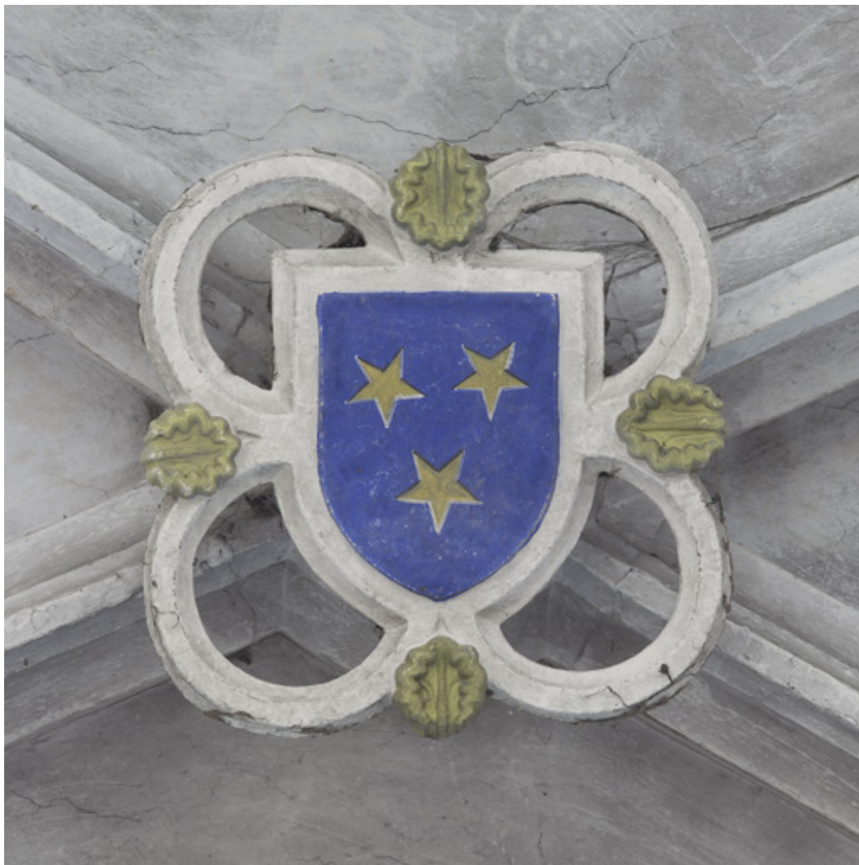
Vue de la clef de voûte n°2.
