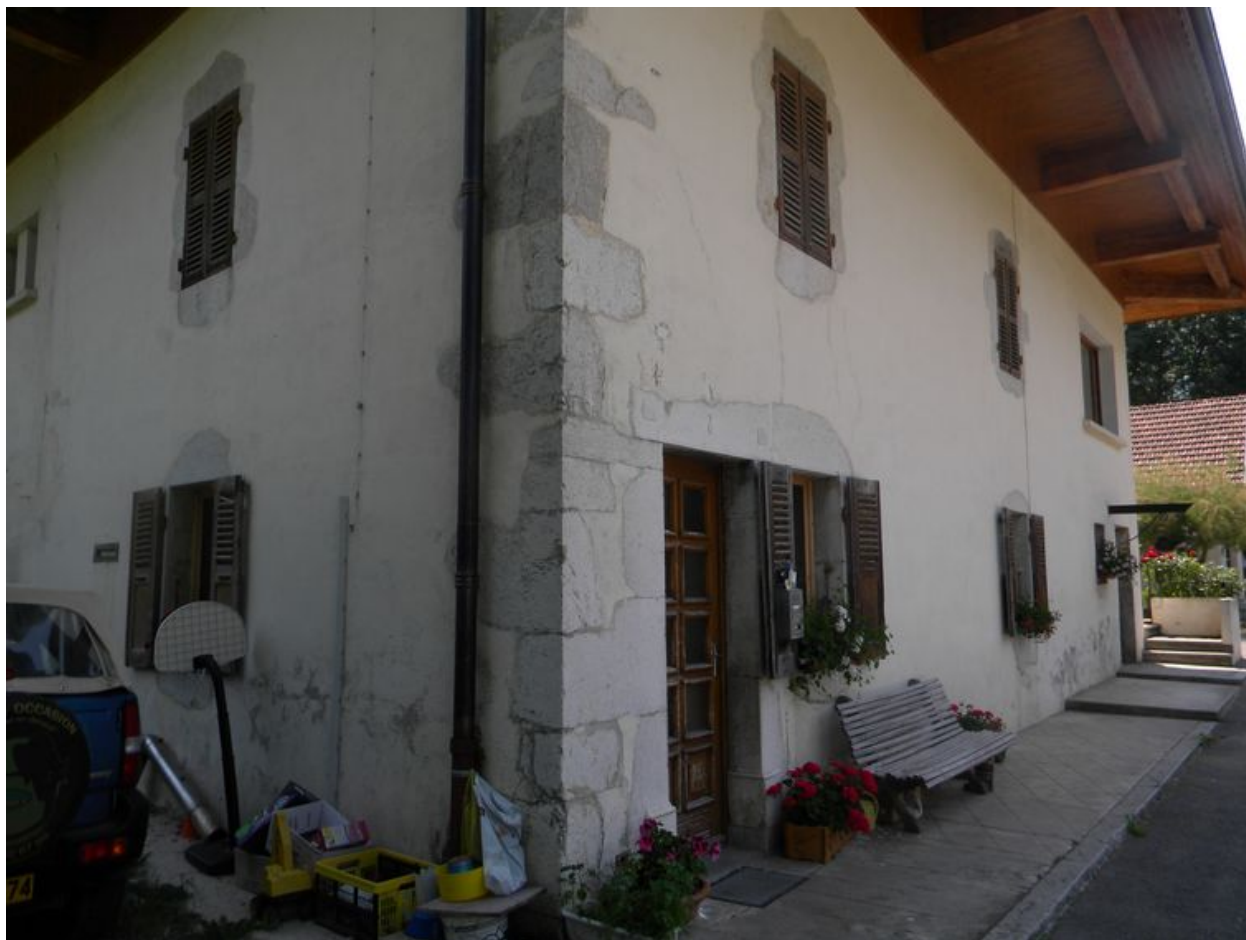
Vue de l'angle nord-ouest avec détail du chaînage.
