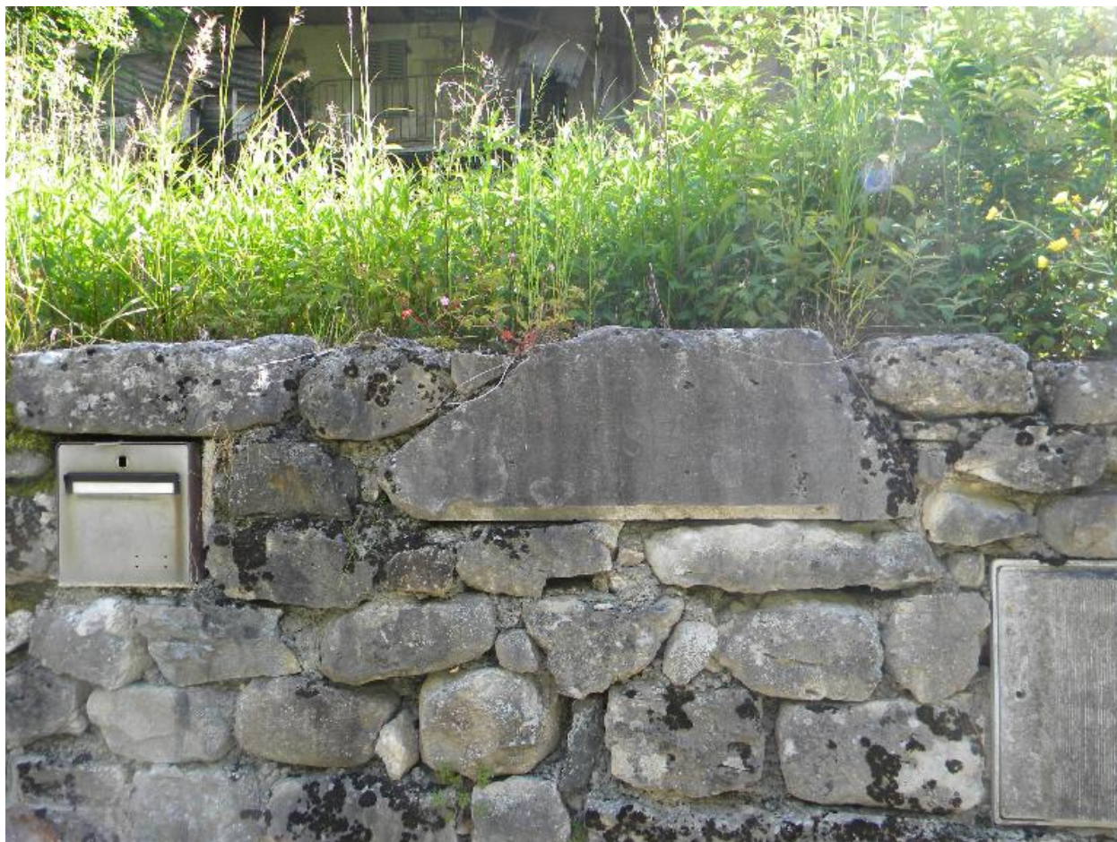
Vue d'une pierre de taille portant la date de 1835 réutilisée dans un mur de soutènement.
