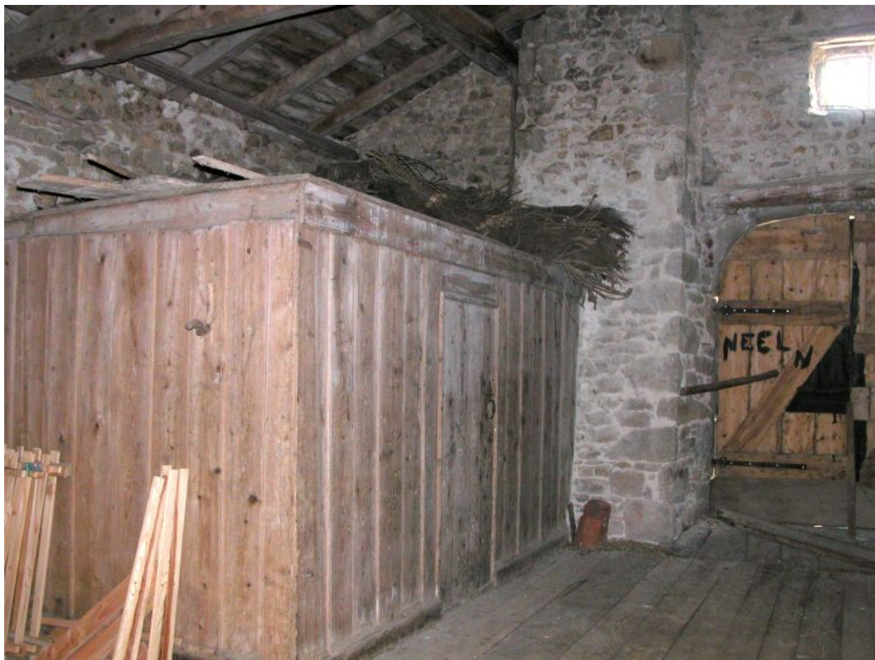
Grange, angle sud-est. Chambre cloisonnée.
