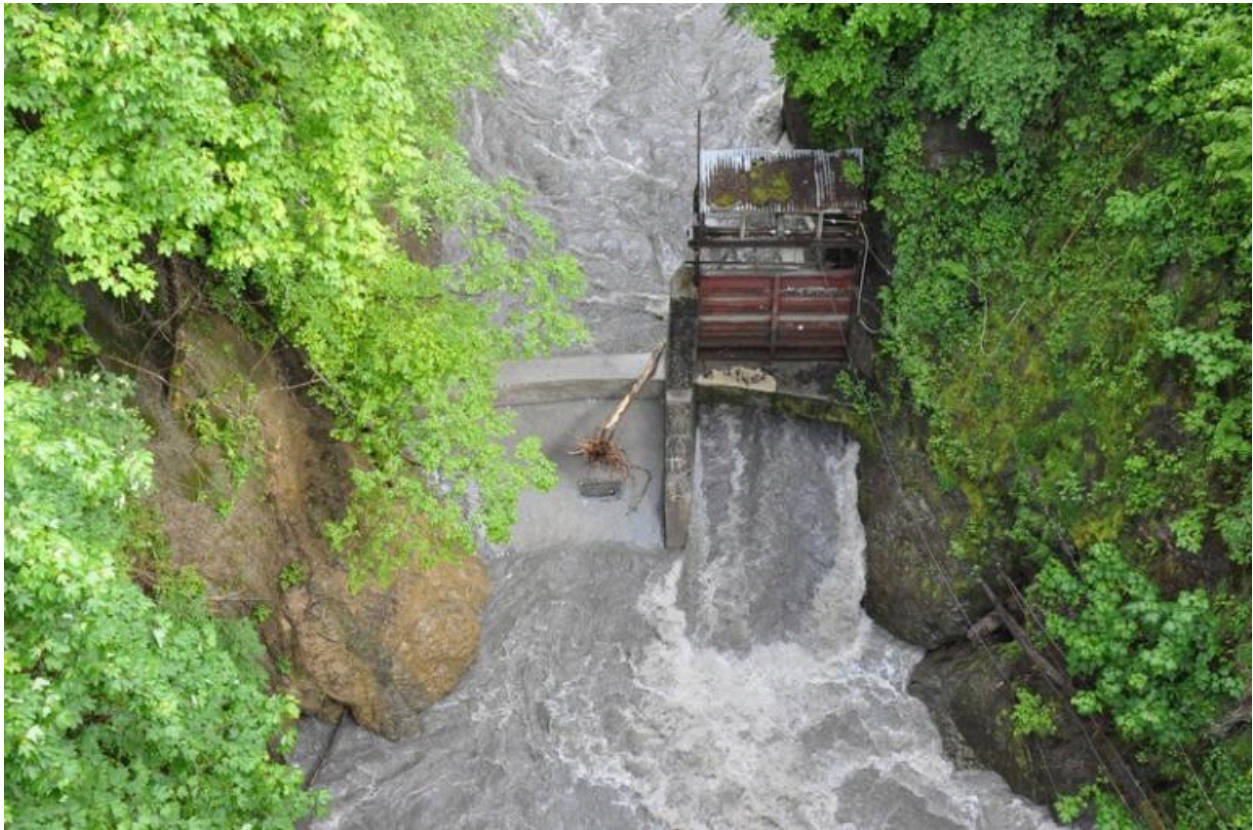
Vue de la prise d'eau depuis le pont Morand.
