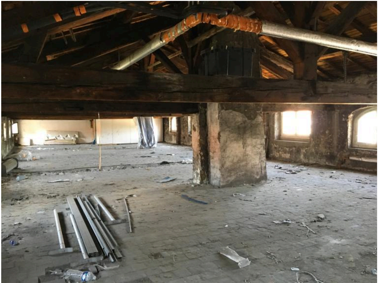
Cour d'honneur, corps de bâtiment est : comble, vue d'ensemble depuis le sud
