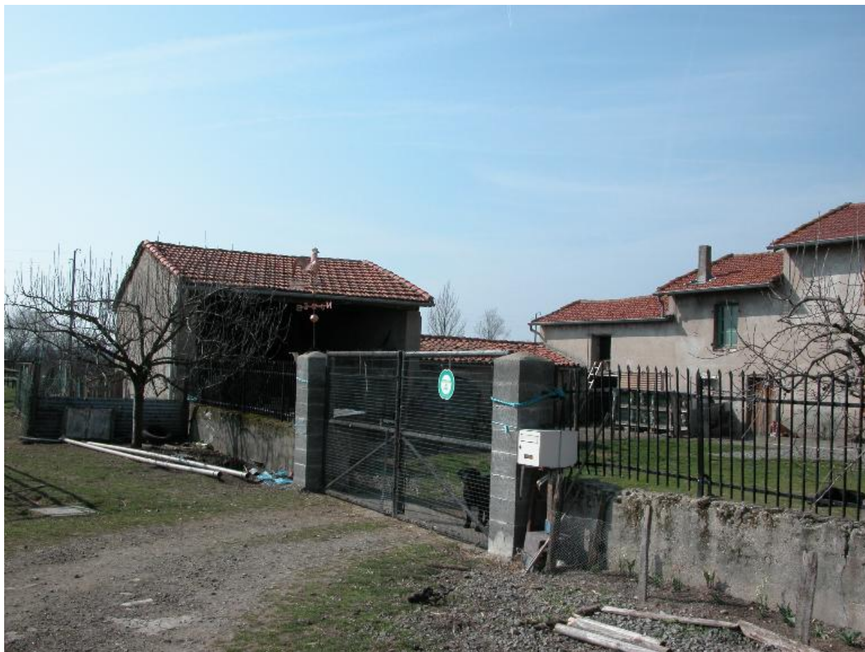
Vue d'ensemble de la remise et de la porcherie.
