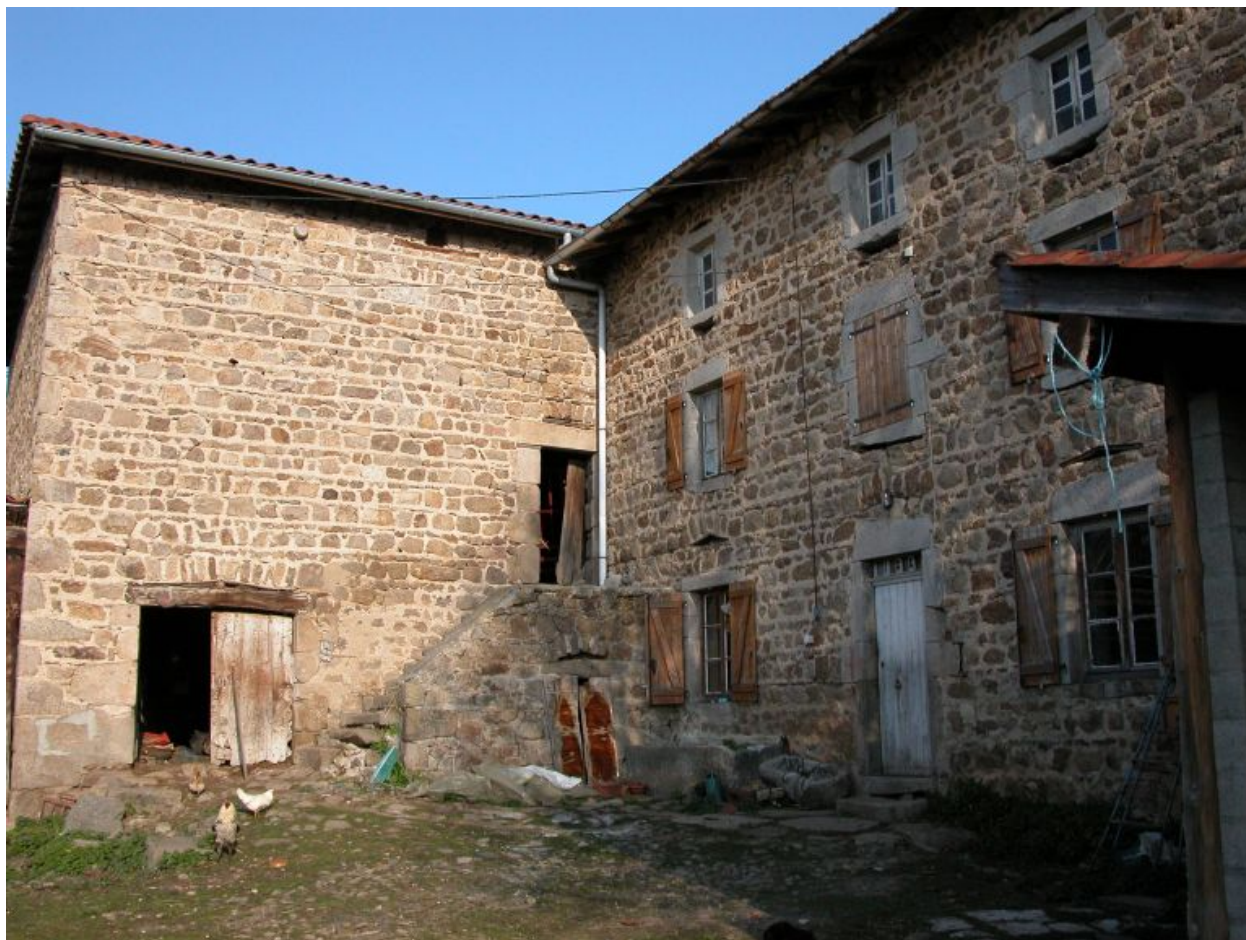
Vue d'ensemble intérieure de la cour : logis et grange-étable.
