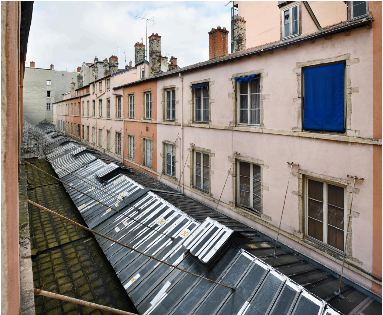
Vue extérieure des immeubles de la partie sud du passage, 2026
