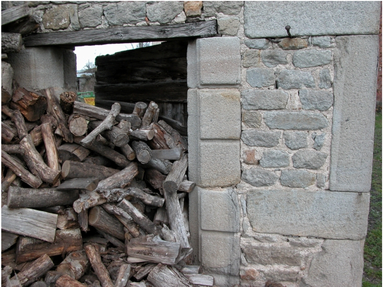
Détail du jambage de la porte à l'angle sud-ouest de la cour 1 : bossage, en remploi.
