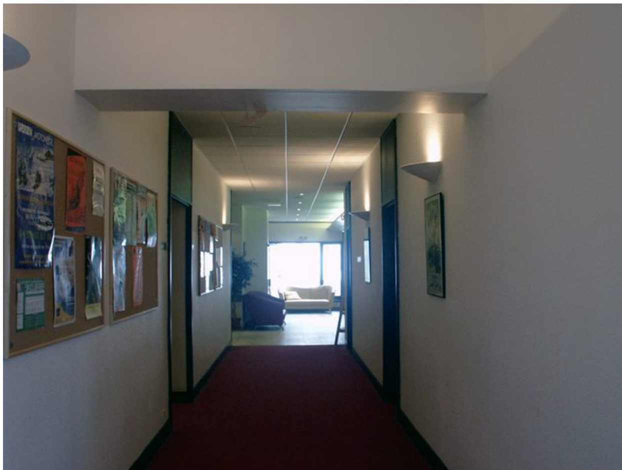
Couloir de distribution des parties communes
