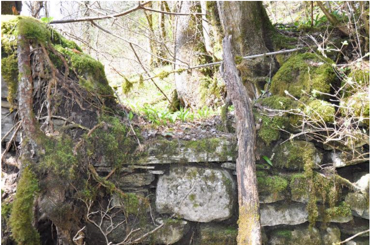
Vue de l'arrivée du bief.
