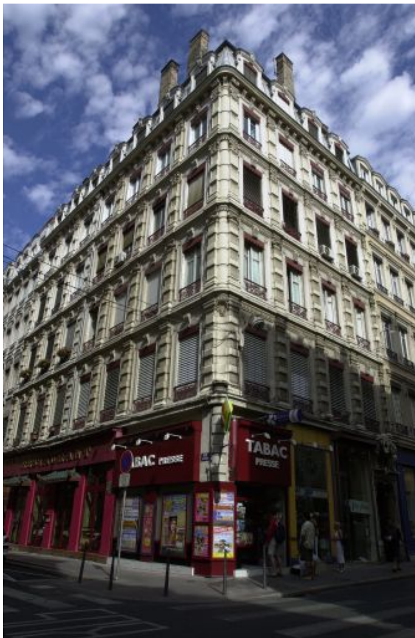
Vue générale des façades
