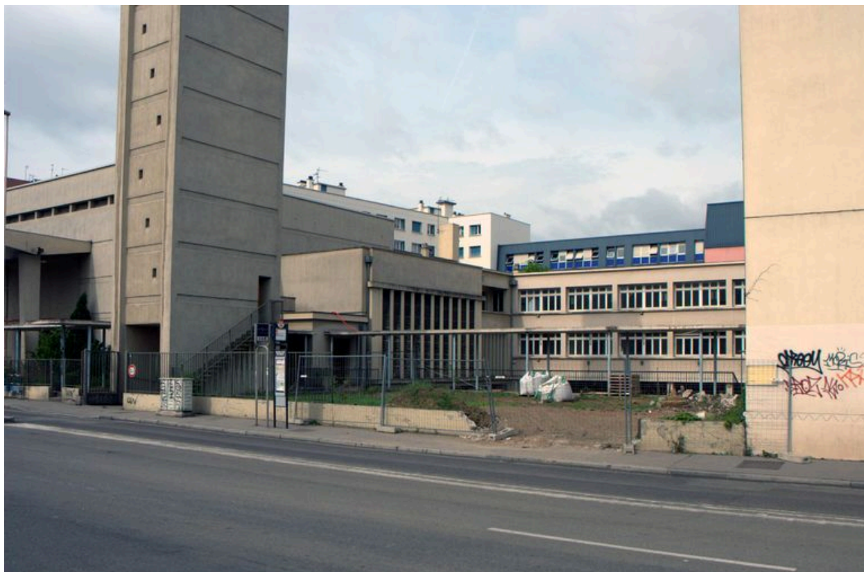
Vue partielle depuis le boulevard des Tchécoslovaques, chantier en cours, mai 2008
