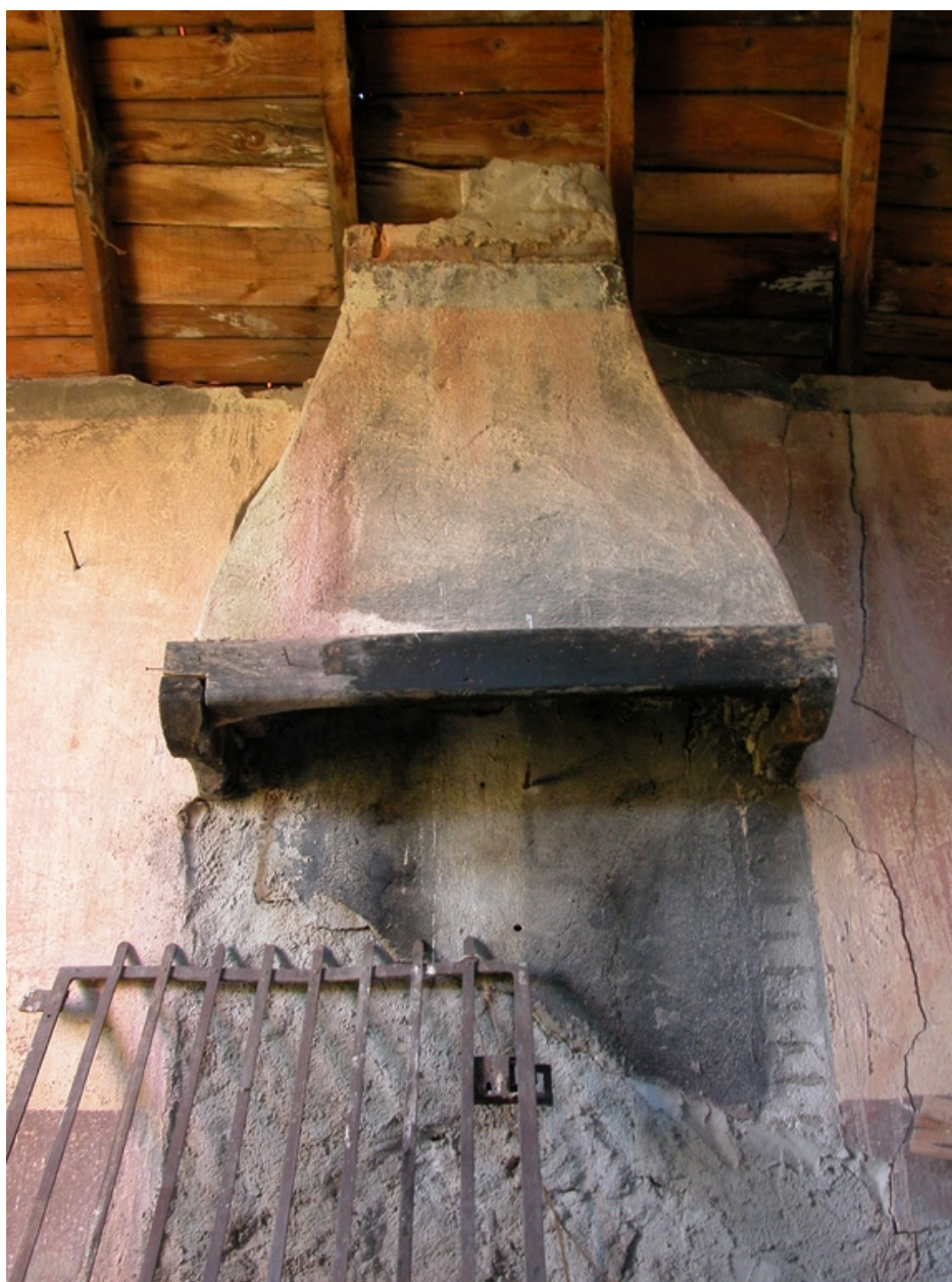
Vue intérieure de l'étage : cheminée.
